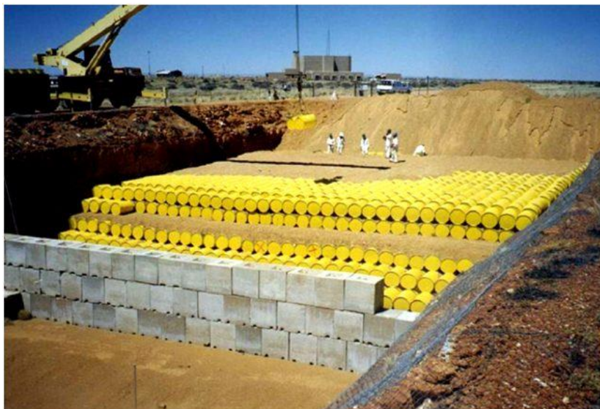
Рис. 12.3. Полигон для промышленных отходов
