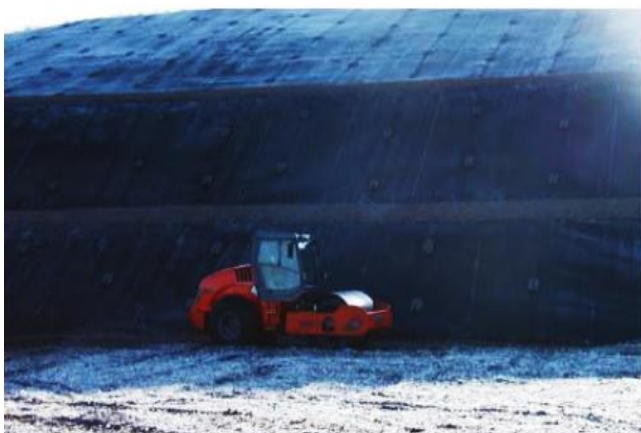
Рис. 7.5. Профилирование и уплотнение поверхности с помощью катка
