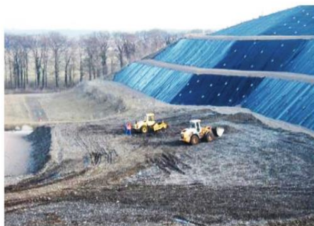
Рис. 7.6. Послойное размещение отходов с помощью катка и бульдозера
