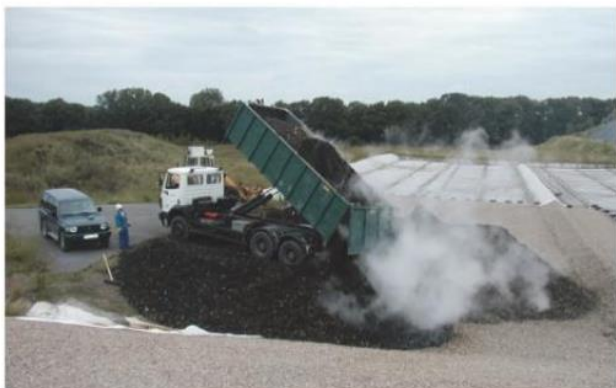
Рис. 7.3. Выгрузка первых материалов на поверхностном фильтрующем слое
