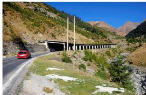
Рисунок 3. Установленные противооползневые сооружения А-373 на перевале «Камчик» автодороги «Ташкент-Ош» и строительство специальных галерей для обеспечения безопасности движения на участках, подверженных оползням
