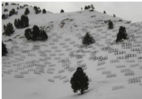
Рисунок 3. Установленные противооползневые сооружения А-373 на перевале «Камчик» автодороги «Ташкент-Ош» и строительство специальных галерей для обеспечения безопасности движения на участках, подверженных оползням
