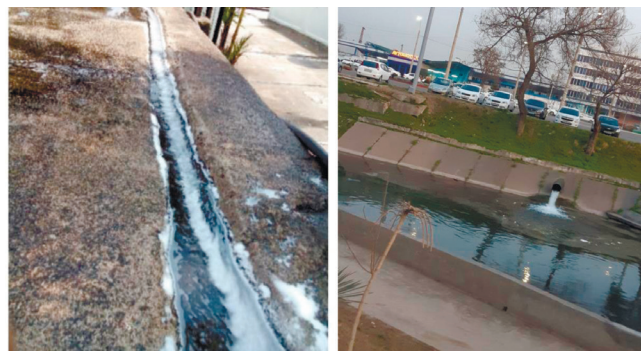
а) – вид отводной канавы для стоков автомойки в Джохаре, б) – сброс стоков автомойки в канал Салар в г. Ташкенте
