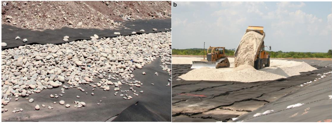
4.7-rasm Chiqindixona poydevoridagi tekislash qatlamini to'ldirish (qum, shag'al)
