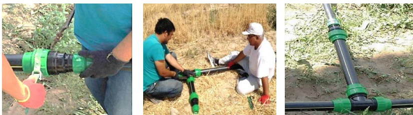
a) yomg‘irlatib sug‘orish tizimining quvurlarini ulash
