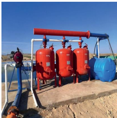
10.5-rasm. Bosh inshootlarning betonlangan maydonchada joylashuvi (nasos qurilmasi, filtrlar, o'g'itlash moslamasi, boshqaruv pulti).
