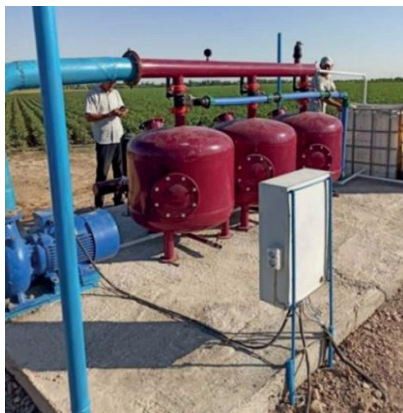
10.5-rasm. Bosh inshootlarning betonlangan maydonchada joylashuvi (nasos qurilmasi, filtrlar, o'g'itlash moslamasi, boshqaruv pulti).
