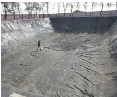
a) bir seksiyali chuqur hovuz a) ikki seksiyali uzun hovuz 5.4-rasm. Hovuz tubi va yonlarini geomembrana bilan qoplash.
