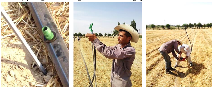
b) yomg‘irlatib sug‘orish tizimining yomg‘ilatgichlarini montaj qilish
