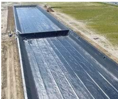
a) bir seksiyali chuqur hovuz a) ikki seksiyali uzun hovuz 5.4-rasm. Hovuz tubi va yonlarini geomembrana bilan qoplash.
