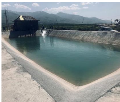
a) beton qoplamali hovuz
