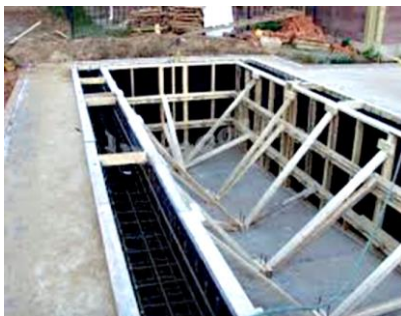
b) yonlarini armaturalab, betonlash
