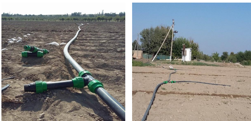
9-расм – Ёмғирлатиб суғориш тизимини буғдой экилган далага ўрнатиш
