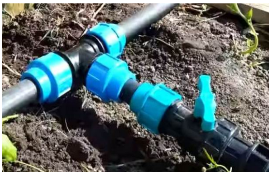
а) тарқатувчи қувур диаметри Ø 25 - 32 мм ли қувур бўлганда
