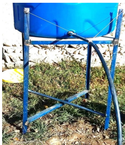
б) бурчак (угол) дан ياسалган ( h=1,2 м)
