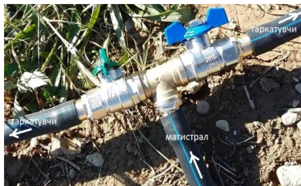
б) латун учлик ва соққали кранлар (магистрал ва тарқатувчи қувурлар диаметри \varnothing 16 мм ли шланг)
