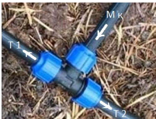
а) компрессион учлик (магистрал ва тарқатувчи қувурлар диаметри \varnothing 25 - 32 мм)
