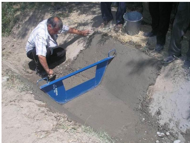
16-расм – Сув ўлчаш воситаси қуриладиган жойда канал туби ва ёнбағирини бетонлаш
