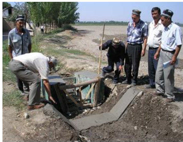
16-расм – Сув ўлчаш воситаси қуриладиган жойда канал туби ва ёнбағирини бетонлаш
