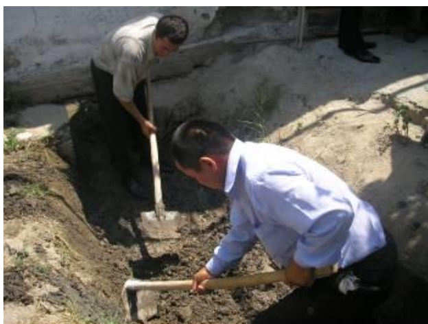
13-расм - Каналнинг гидропост қуриладиган ўзанини тозалаш
