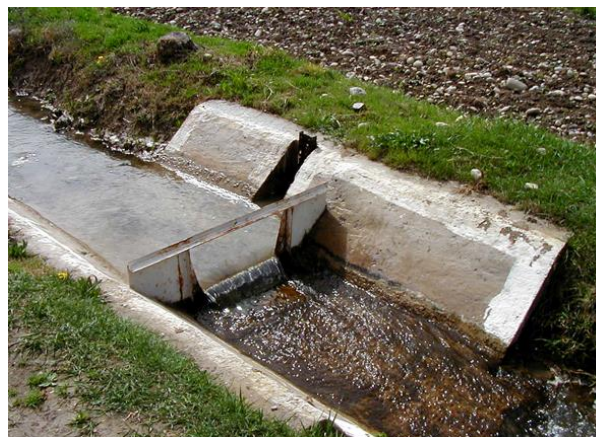
2-расм – Чиполетти водосливи асосидаги гидропост
