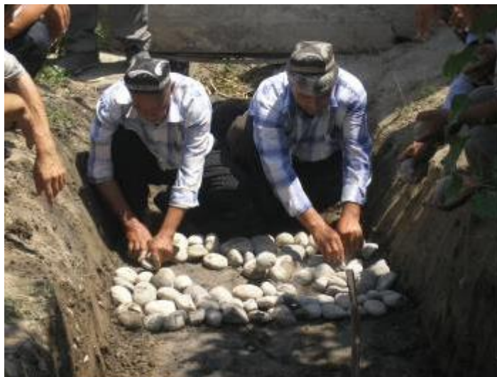
14-расм - Каналнинг гидропост қуриладиган қисмига тош ётқизиш
