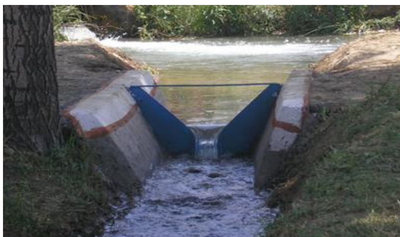
1-расм – Томсон водосливи асосидаги гидропост
