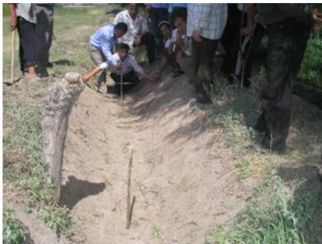
12-расм - Каналнинг гидропост қуриладиган қисмини белгилаш
