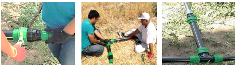
a) yomg'irlatib sug'orish tizimining quvurlarini ulash
