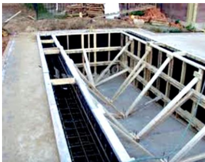
b) yonlarini armaturalab, betonlash
