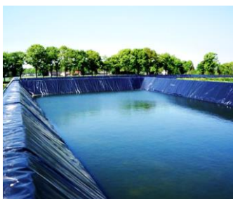
5.5-rasm. Geomembrana bilan qoplangan hovuzning ko'rinishi.
