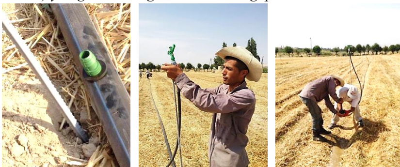
b) yomg'irlatib sug'orish tizimining yomg'ilatgichlarini montaj qilish
