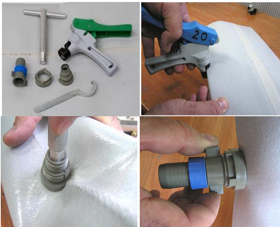
5.2-расм – Томчилатиб сугориш тизимини тарқатувчи қувурига штуцерларни ўрнатиши
