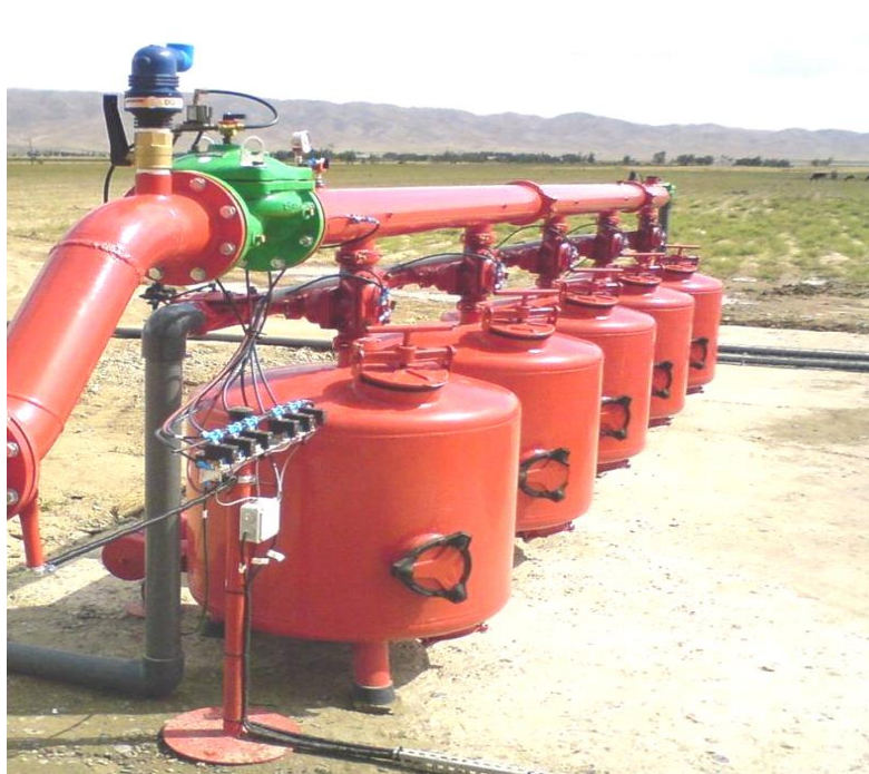
3.3-расм - Томчилатиб суғориш тизимида ишлатиладиган бир камерали қумли фильтр
