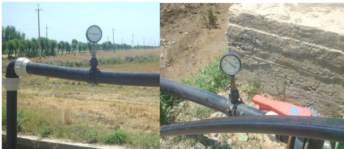
3.16-расм – Томчилатиб сугориш тизимининг босимни назорат қилувчи манометрлари
