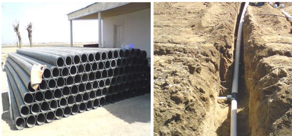
3.9-расм – Томчилатиб суғориш тизимининг магистрал қувури полиэтилендан тайёрланади ва ер остига ётқизилади
