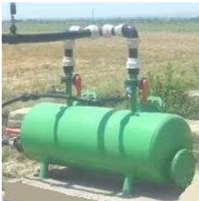
3.4-расм - Томчилатиб суғориш тизимида ишлатиладиган икки камерали қумли филтранинг кўриниши
