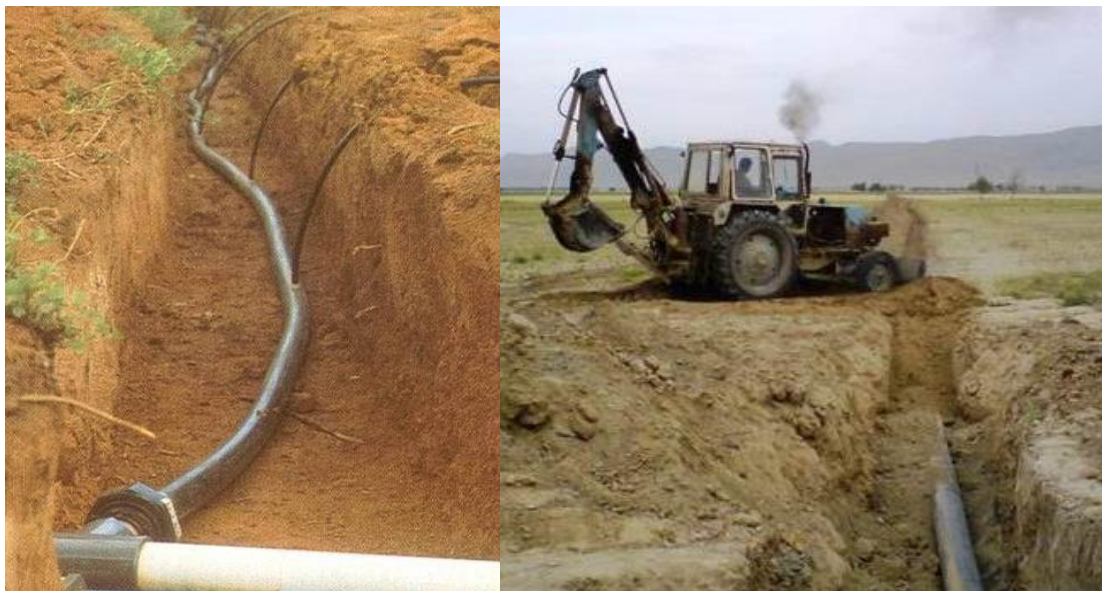
5.3-расм – Томчилатиб суғориш тизимини тарқатувчи қувурини траншеяга жойлаштириши ва траншеяни тупроқ билан қайта қўмиши
