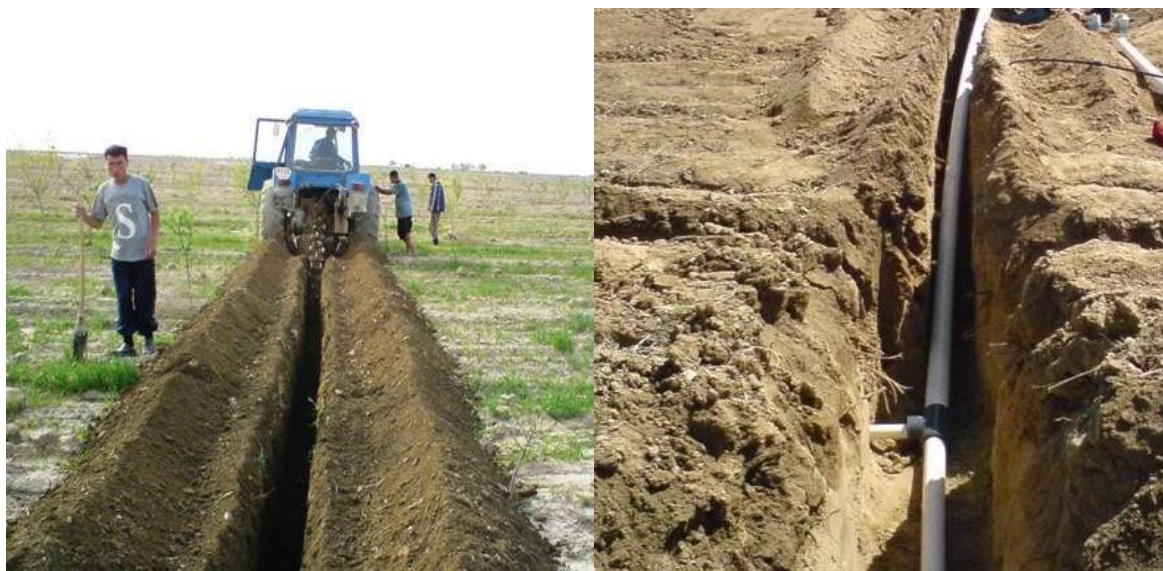
5.1-расм – Томчилатиб сугориш тизимини магистрал қувурини қуриши
