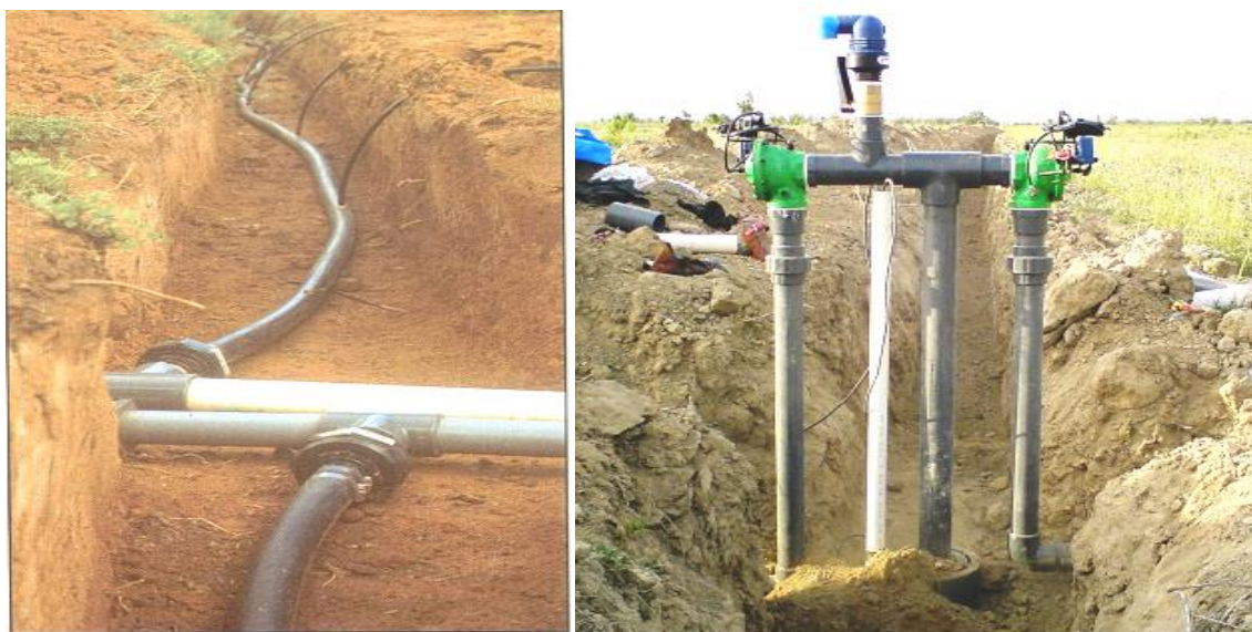
3.10-расм – Тарқатувчи қувурлар бош қувурга тўғридан-тўғри ёки сувни бошқарувчи гидрантлар ёрдамида уланади
