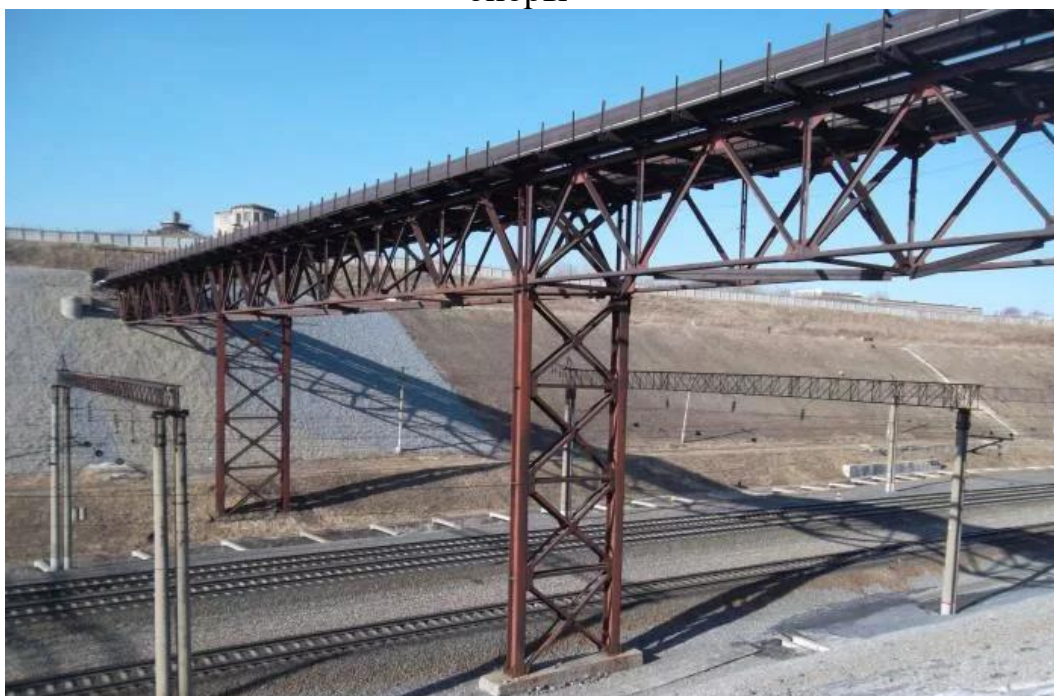
Рис. 6.9. Трубопроводная эстакада через железнодорожные пути
