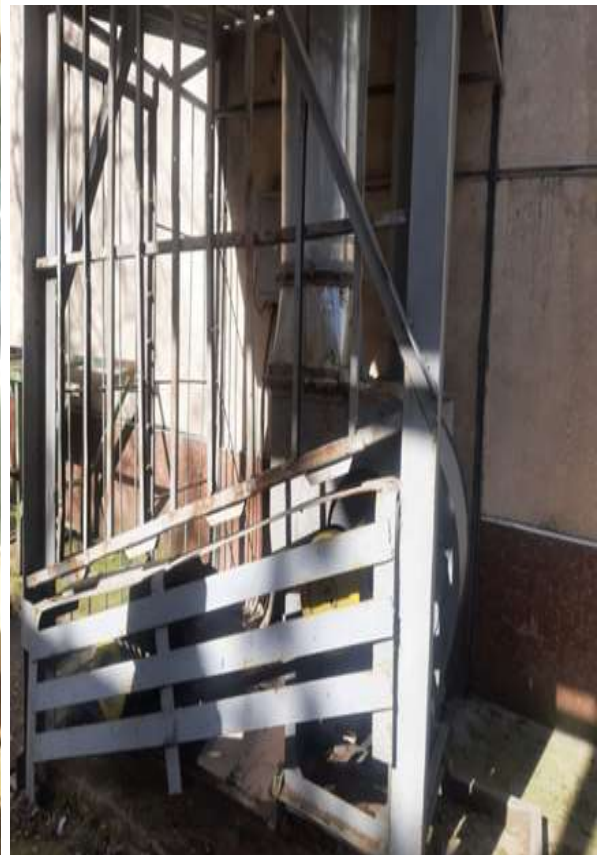
3.2-rasm. TIQXMMI-MTUda O'quv ustaxonada arra ishlatish vaqtida undan chiqadigon apelpalarni yig'ish dudboron
