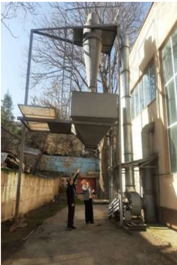
3.2-rasm. TIQXMMI-MTUda O'quv ustaxonada arra ishlatish vaqtida undan chiqadigon apelpalarni yig'ish dudboron
