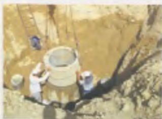
Рис.11. Монтаж секций верхних частей колодцев
