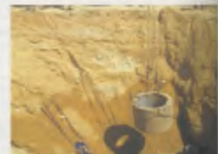
Рис. 2. Смотровые колодцы К 20 и К 20 а с заглушенными деревянными пробками дренажными трубами
