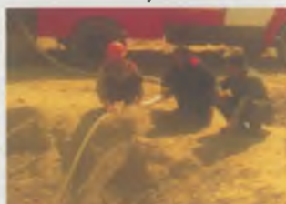
Рис.5. Промывка существующей трубы дренажа с помощью пожарной машины
