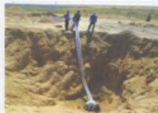
Рис. 9. Производство работ по протаскиванию гофрированных пластмассовых труб во внутрь существующей асбоцементной трубы
