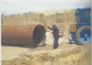
Рис.6. Строительство дополнительного смотрового колодца К 20 б
