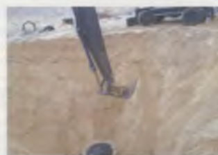
Рис.3. Разработка грунта вокруг смотровых колодцев К 20 и К 20 а экскаватором
