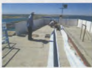
Рис. 8. Процесс обертки ЗФМ (геотекстиль) гофрированных пластмассовых труб
