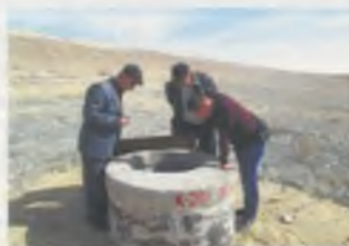
Рис. 2. Смотровые колодцы К 20 и К 20 а с заглушенными деревянными пробками дренажными трубами
