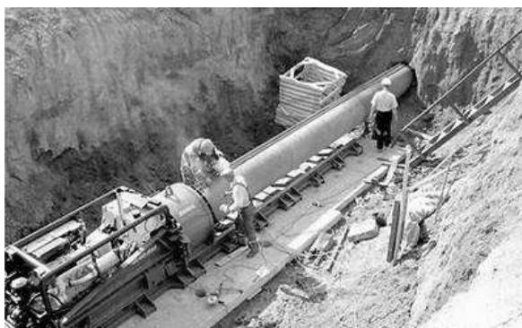
**Рисунок 7. Общий вид шнековой буровой машины БШМ BARBCO ABM 60-1 HD для сооружения новой трубы методом горизонтального бурения**
