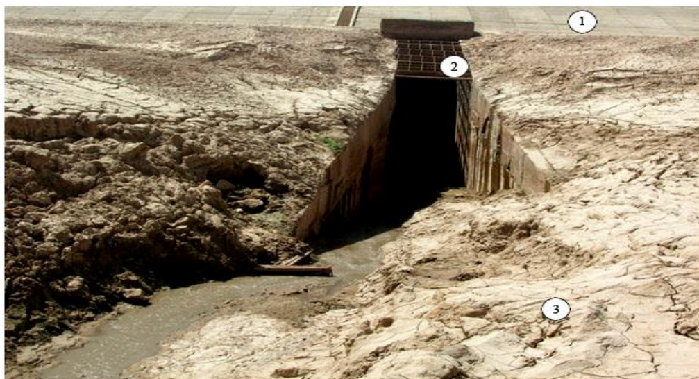
1-расм. Қалқама сув омбори юқори бьефи сув чиқазгич иншооти зонасининг hozirgi xolati. 1- тўғон юқори қиялиги; 2-сув чиқазгич иншооти қаллаги; 3-лойқа ётқизиклари;
