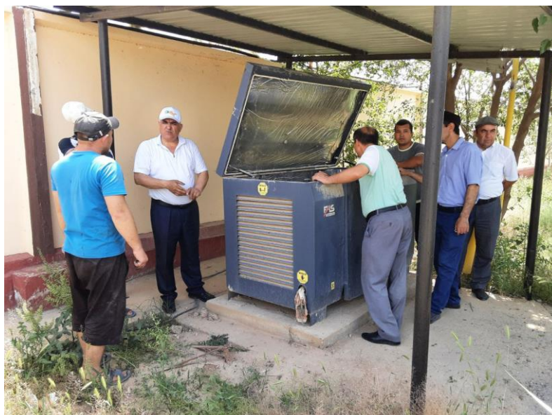
28-расм. Биогазда ишлайдиган электрогенератор
