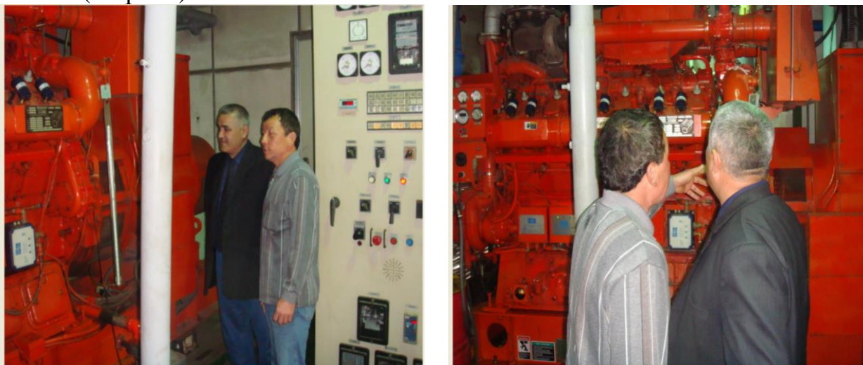
29-расм. Биогазда ишловчи дизел двигатели (Жунубий Корея)
