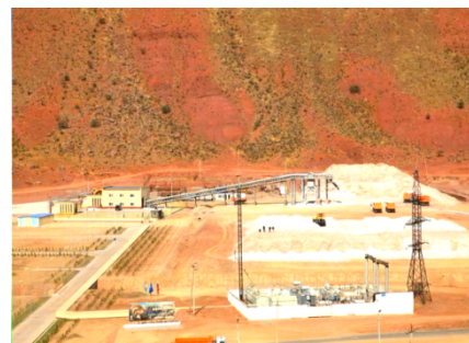
5-расм. Сильвинит рудалари таркиби кимёвий ва физик саноатбоп кондицион ўлчамга эга бўлиши учун дастлабки тайёрлаш ва сақлаш майдони
