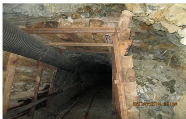
2-расм. 3-штольня 5-штрекда тоғ жинслари ер ости сувлари таъсирида намланиши натижасида қулаб тушиши қайд этилди.
