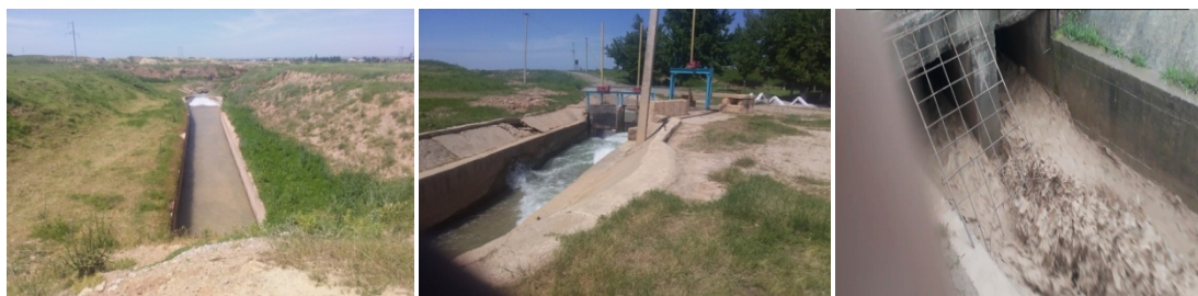
4-расм. Лангар сел-сув омборидан сел-тошқинларни ўтказишдан сўнг сув чиқариш иншоотидаги носозликлар
