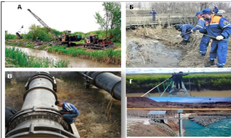
1 Расм. Гидромелиоратив тизим иншоотларида бажарилаётган иш жараёнлари: А-канални механик усул билан лойқадан тозалаш; Б-Завур тўсилган(кўмилган) жойини кўл кучи билан очиш; В-металл тузилмаларни таъмирлаш; Г-сув ўлчаш ишлари ва қурилмалари.
