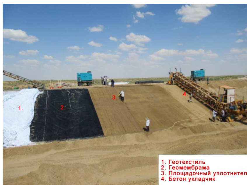
Рис.3. Укладка бетона, геомембраны и геотекстиля на откосах канала
