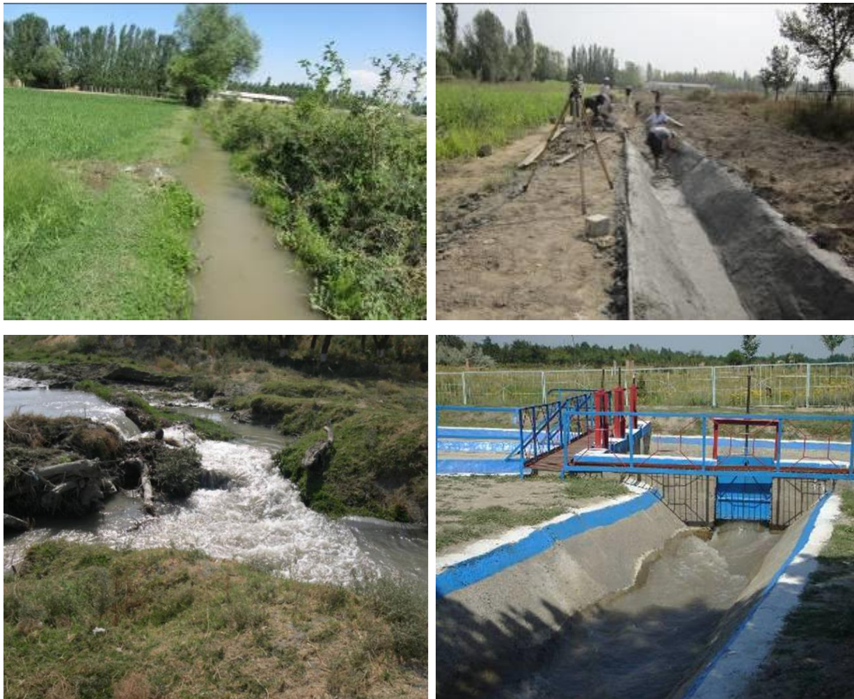
4.7.1-rasm. Sug‘orish kanal va taqsimoti inshootining ta‘mirlashdan odingi va keyingi xolati.
