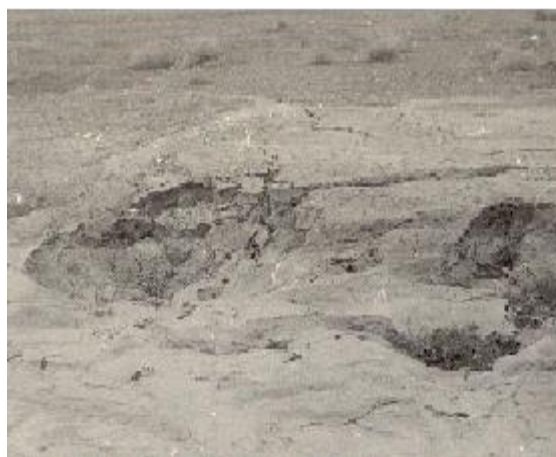
3.7.1-rasm. Sugʻorish kanalining buzilishi xamda yer yuzasining choʻkish jarayoni.
