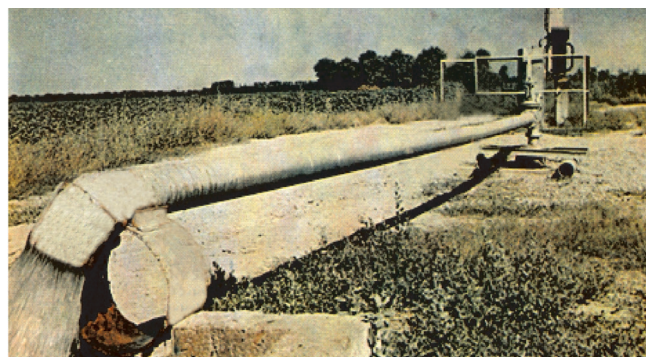
Рис.1. Оголовок скважины вертикального дренажа
