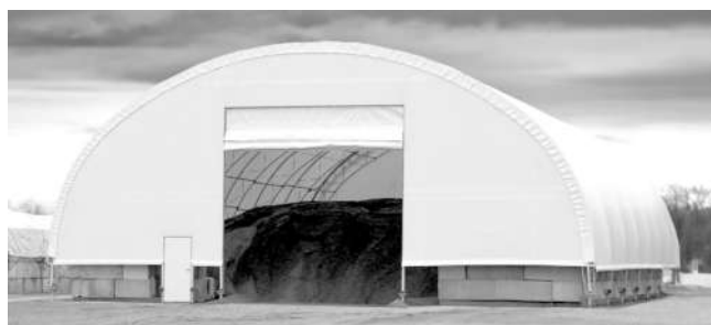
1-rasm. Donni saqlash uchun mato bilan qoplangan ixtisoslashgan bino.
