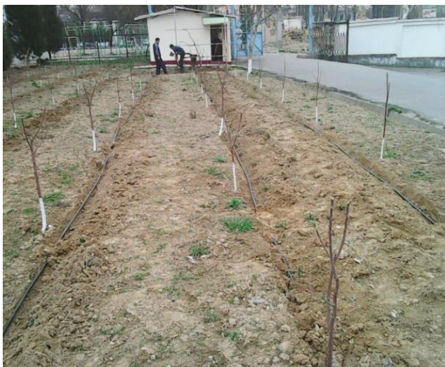
Расм 1: ТИМИ паст босимли томчилатиб суғориш тизимини жойлаштириш жараёни.
