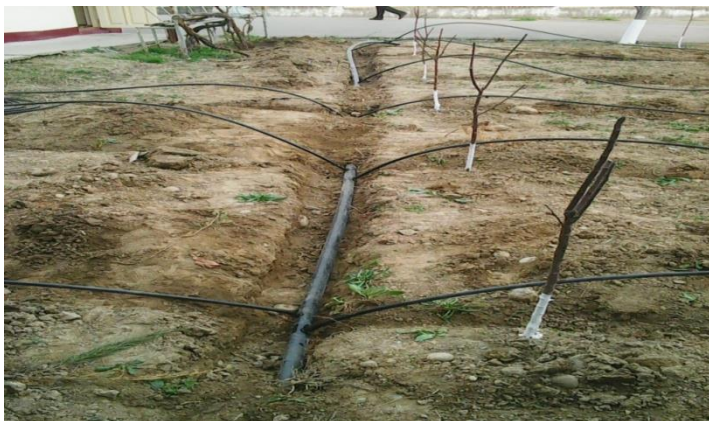
Расм 2: Паст босимли томчилатиб суғориш тизимини монтаж қилиш жараёни.
