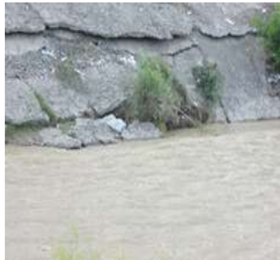
Рисунок 1. Деформационные процессы в нижнем бьефе водопропускного сооружения [2].
