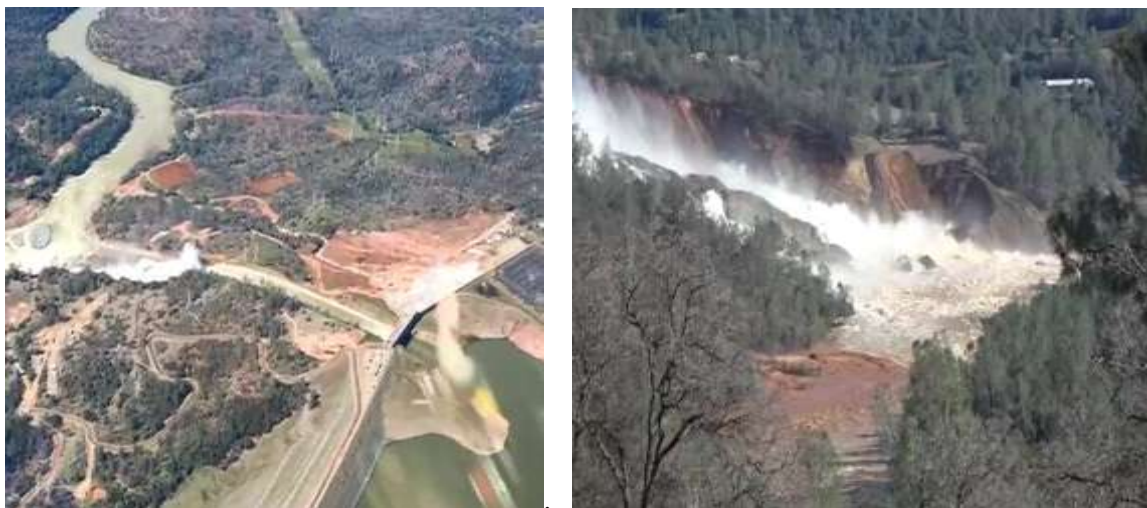
Рисунок 2. Разрушение нижнего бьефа водосбросного сооружения Оровилла.
