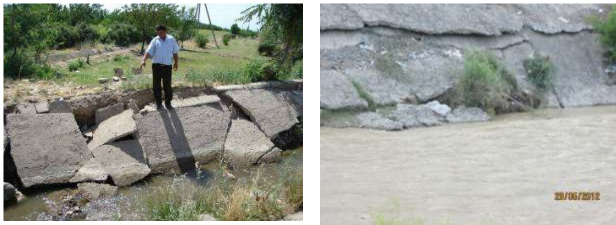
2-расм. Ўрта ва паст напорли гидроузеллар сув чиқариш иншоотлари пастки бьефидаги чиқиш канали ўзанларидаги деформацион жараёнлар (Самарқанд вилояти ҳудудидаги Оқ-Қорадарё гидроузели пастки бьефи)
