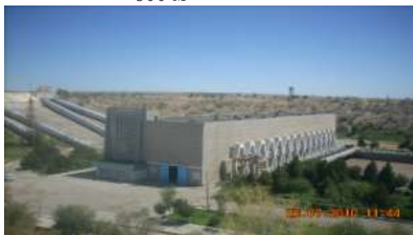
2-Расм. Қизилтепа насос станцияси.
