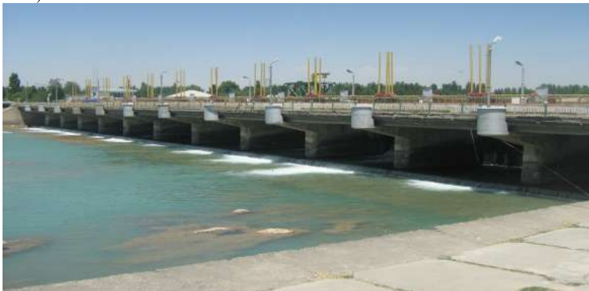
Фото 1. Водосбросная плотина Учкурганского гидроузла (вид с нижнего бьефа).
