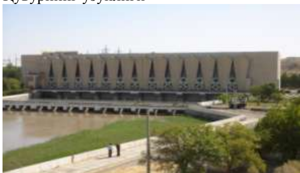
1-Расм. Ҳамза-2 насос станцияси биносининг кўриниши.
