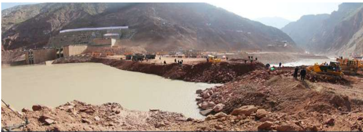
Рис. 3. Начало строительство Рогунской ГЭС (октябрь 2016 г.)
