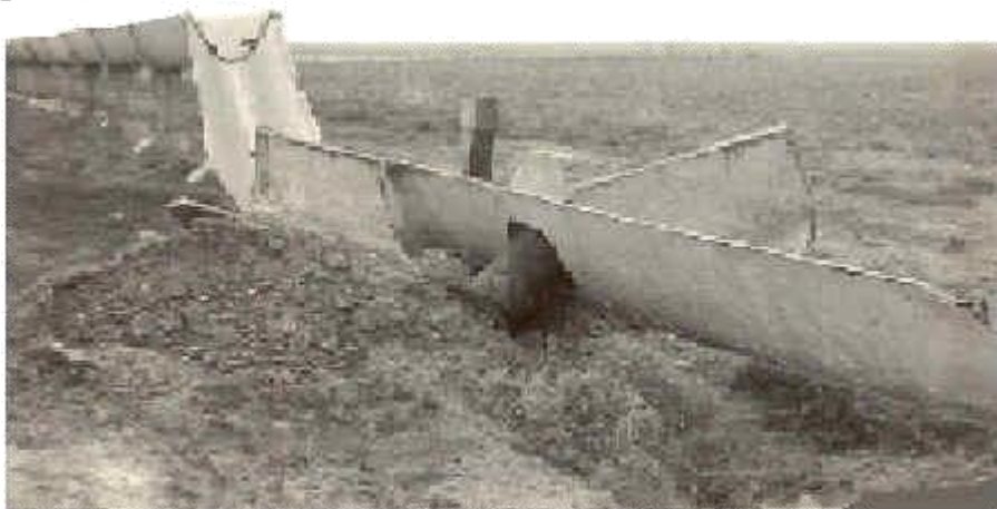
2-расм. Бетон ариқчалари тизимининг суффозия натижасида бузилиши (Бухоро вилояти)
