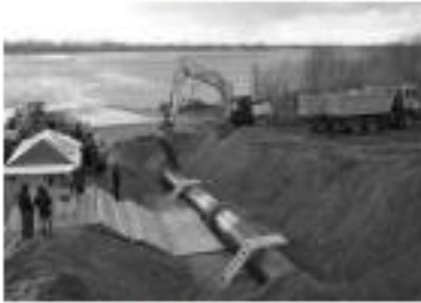
2 – rasm. Dyukerni yer usti sathiga joylashtirish jarayoni.[9]
