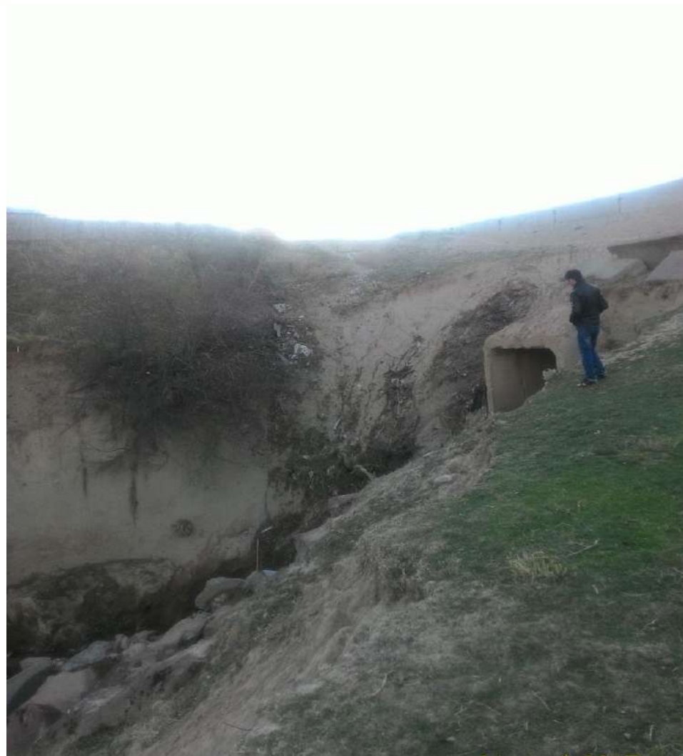
Алвастисой сел ва сув тошқинлари оқибатида 4Р-12 автомобил йўлининг 59 км даги ҳолати.
