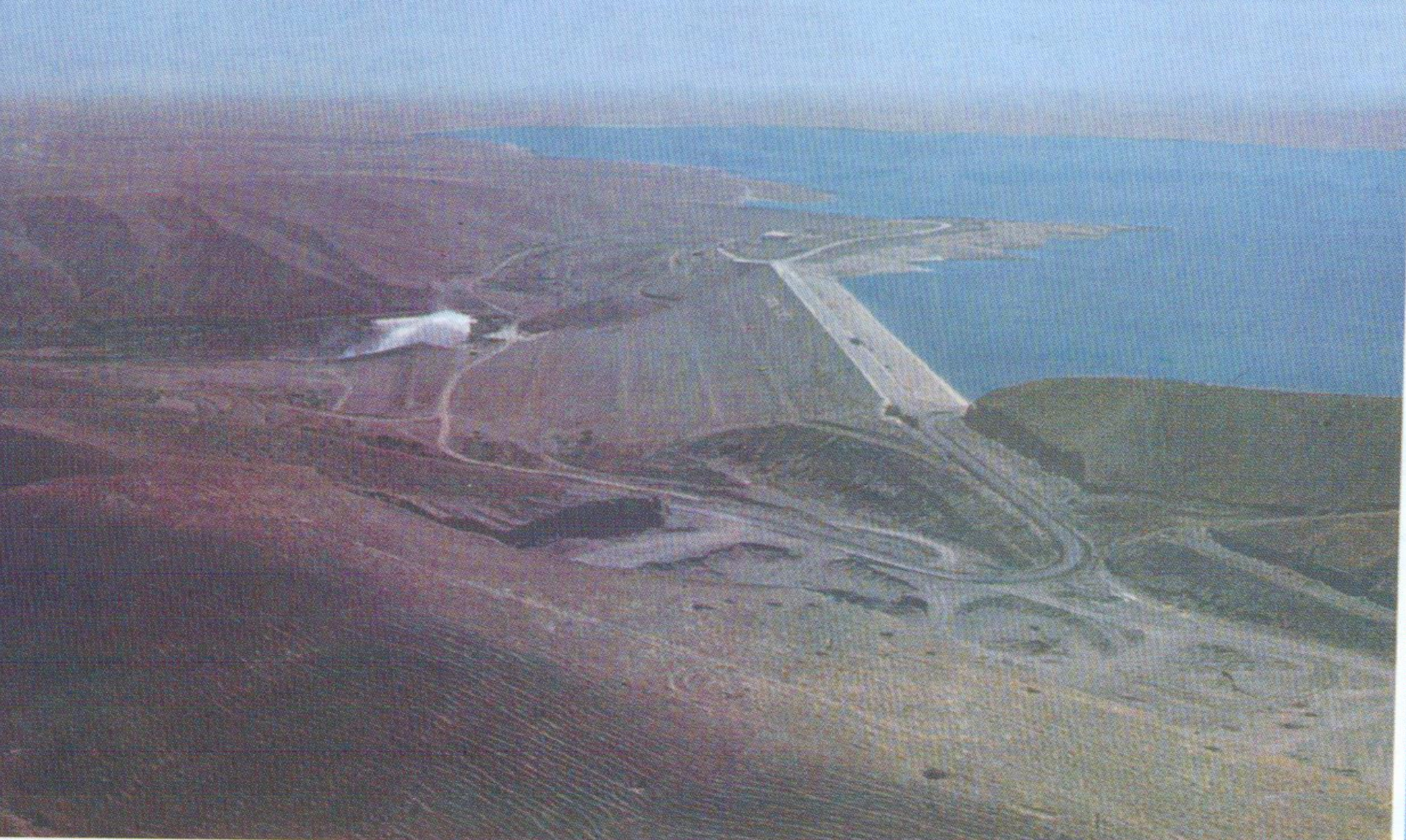
Плотина Каркидонского гидроузла на реке Кувасай, Узбекистан высота плотины – 70 м; объем водохранилища – 218,4 млн.м 3
