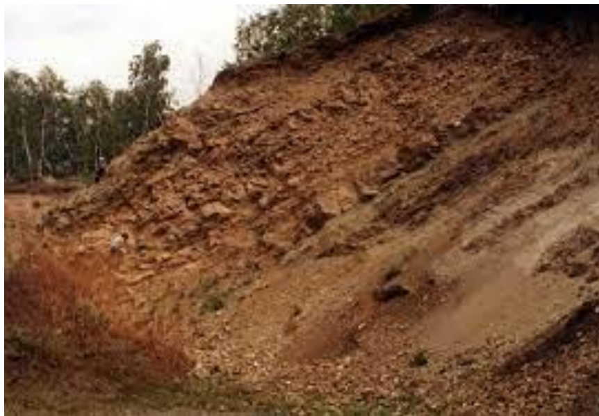
Рис. 3.4. Поверхностный оползень на суглинистом склоне
