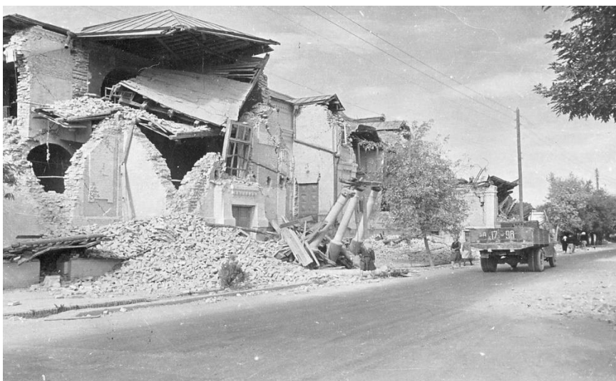
Рис. 3.17. Фотографии повреждений при Камашинском землетрясений 2000 г.
