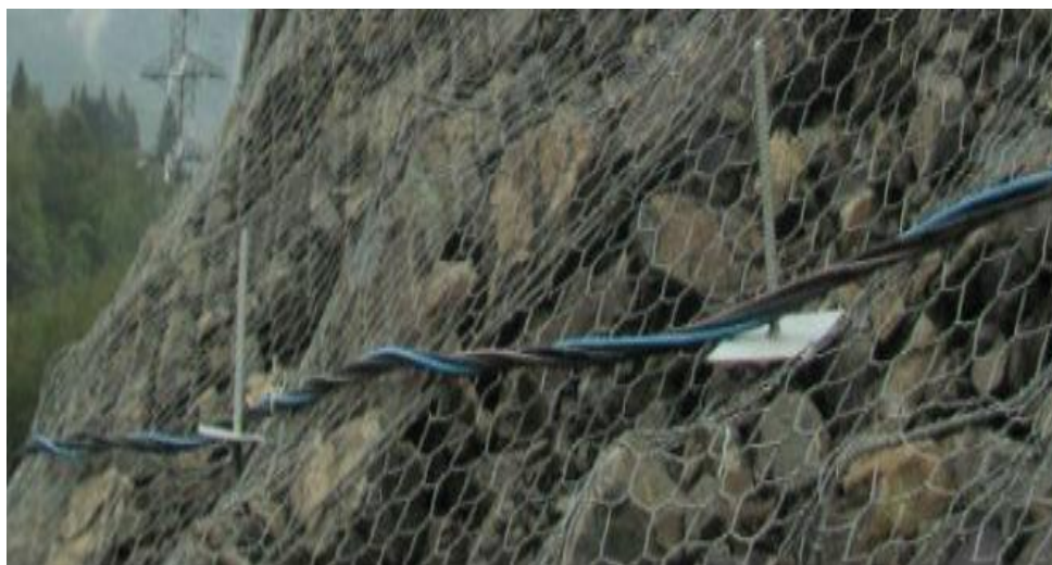
Рис. 3.8. Улавливающие сооружения для защиты от камнепадов
