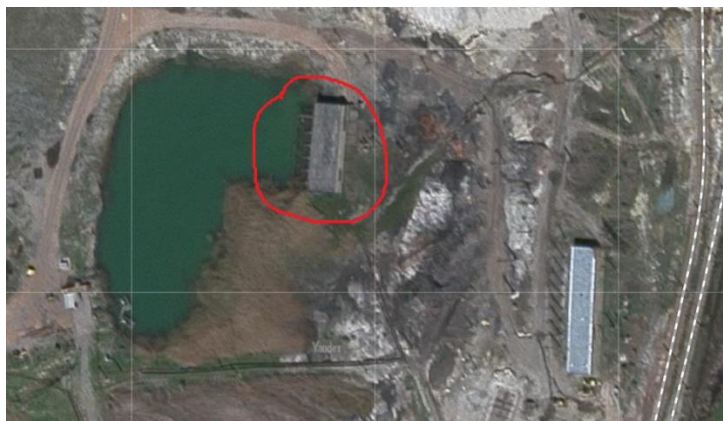
Рис. 5. Насосная станция разреза «Ангренский»
