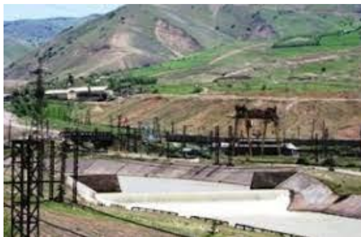
Рис. 4. Обводной канал с водобойными гасителями энергии
