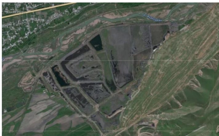
Рис. 6. Гидротехнические сооружения – водосливные карты «гидроотвала»
