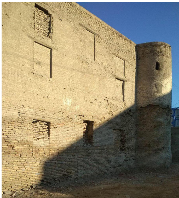
4-расм. Абдулазизхон мадрасаси биносининг жанубга қараган (шарқ деворга яқин қисми) деворининг қониқарсиз техник ҳолати (2019 йилги сурат)
