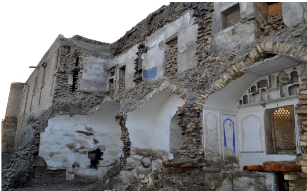
3-расм . Абдулазизхон мадрасаси биносининг шарқий деворининг бир қисми кулагандан кейинги ҳолатининг 2018 йилдаги тасвири
