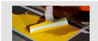
Разметка холодным пластиком
