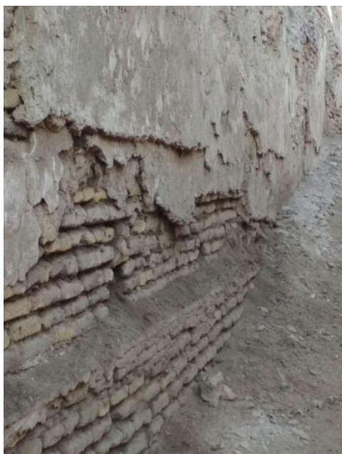
6-расм. Абдулазизхон мадрасаси биносининг шаркка қараган девори фрагменти; қурилиш қоришмаси тўлик, ғиштлар қисман емирилган
