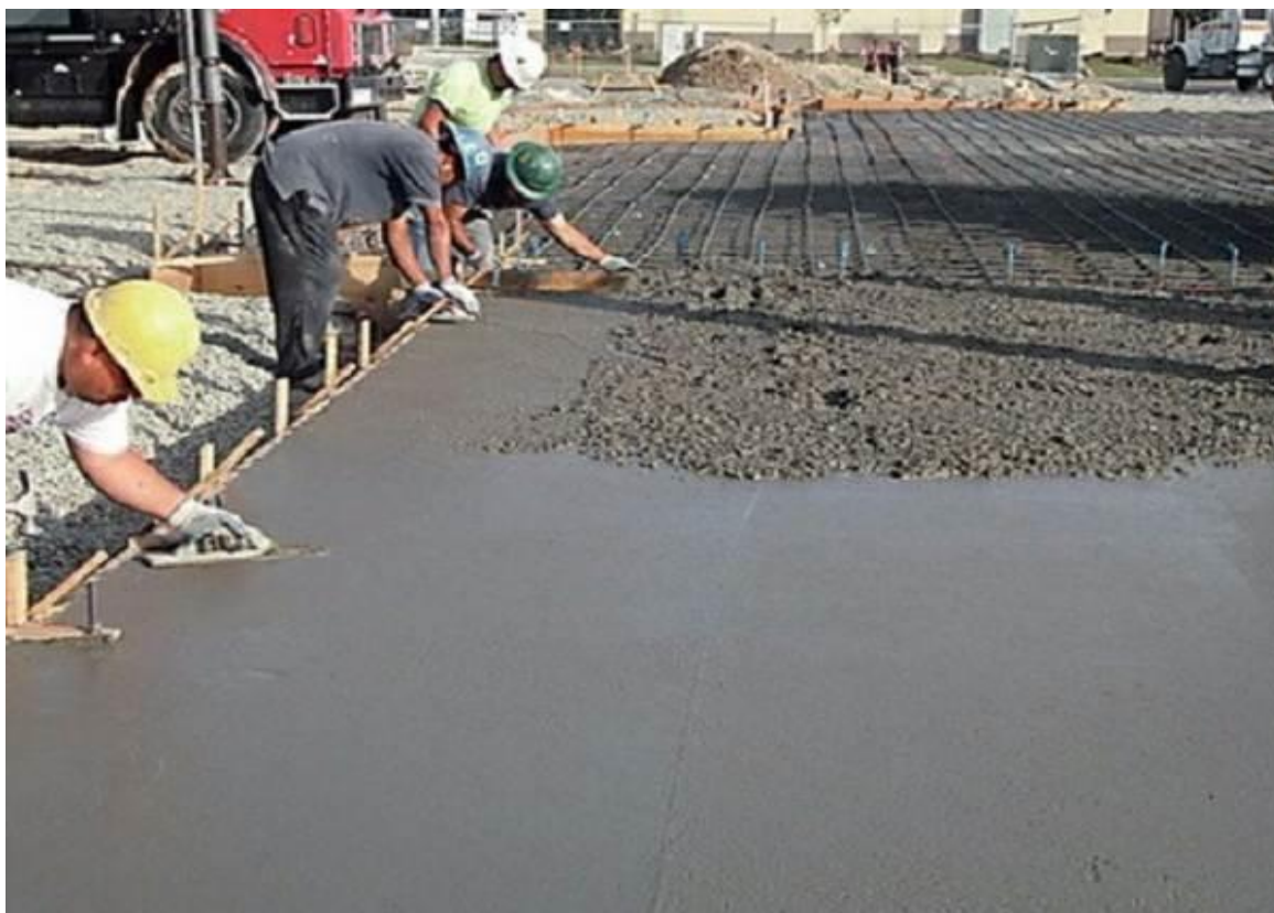
1-расм. бетон қоришмасини пластификаторлар қўллаб ётқизилиши
