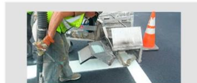
Разметка термопластиком
