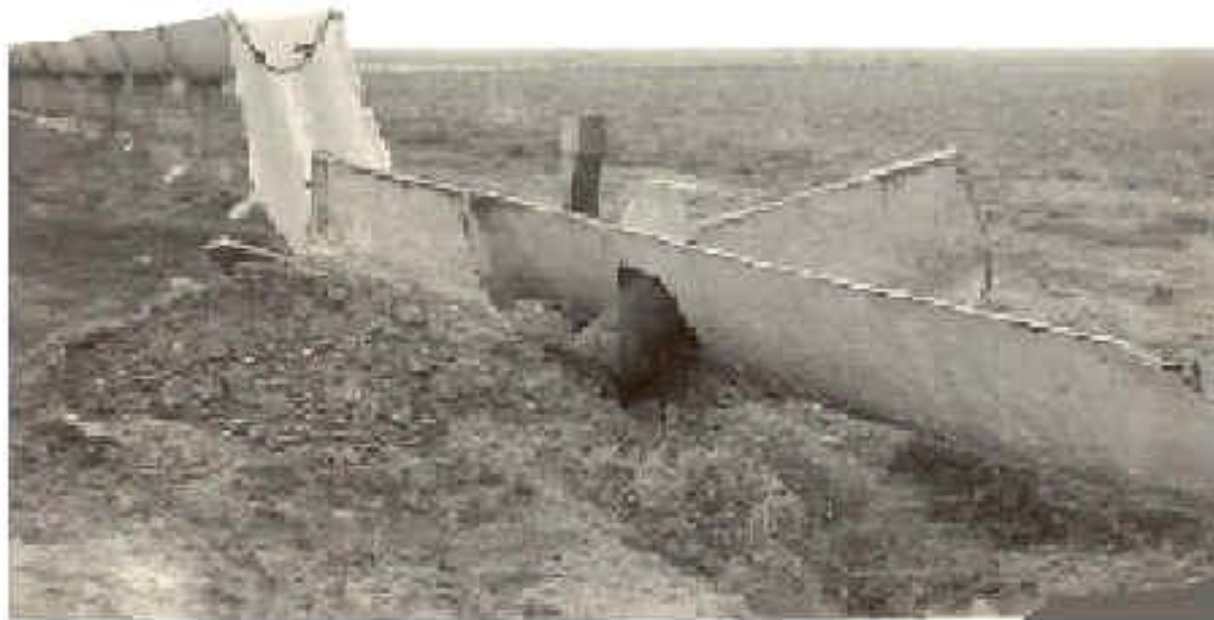
42-расм. Бетон арикчалари тизимининг суффозия натижасида бузилиши (Бухоро вилояти)
