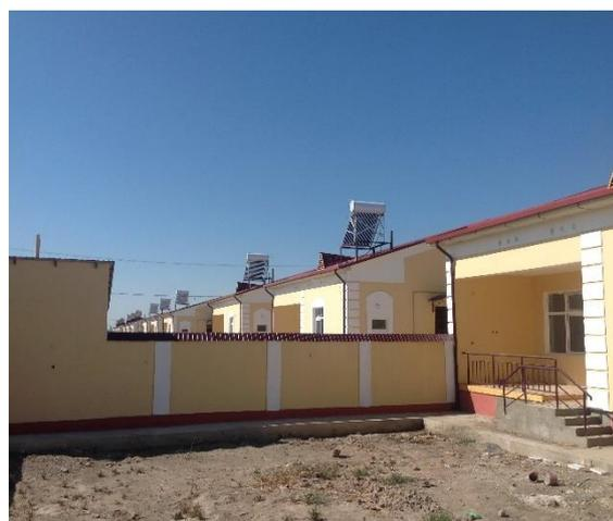
*Рис. 6. Горячее водоснабжение на массиве индивидуальных жилых домов в Хорезмской области*
