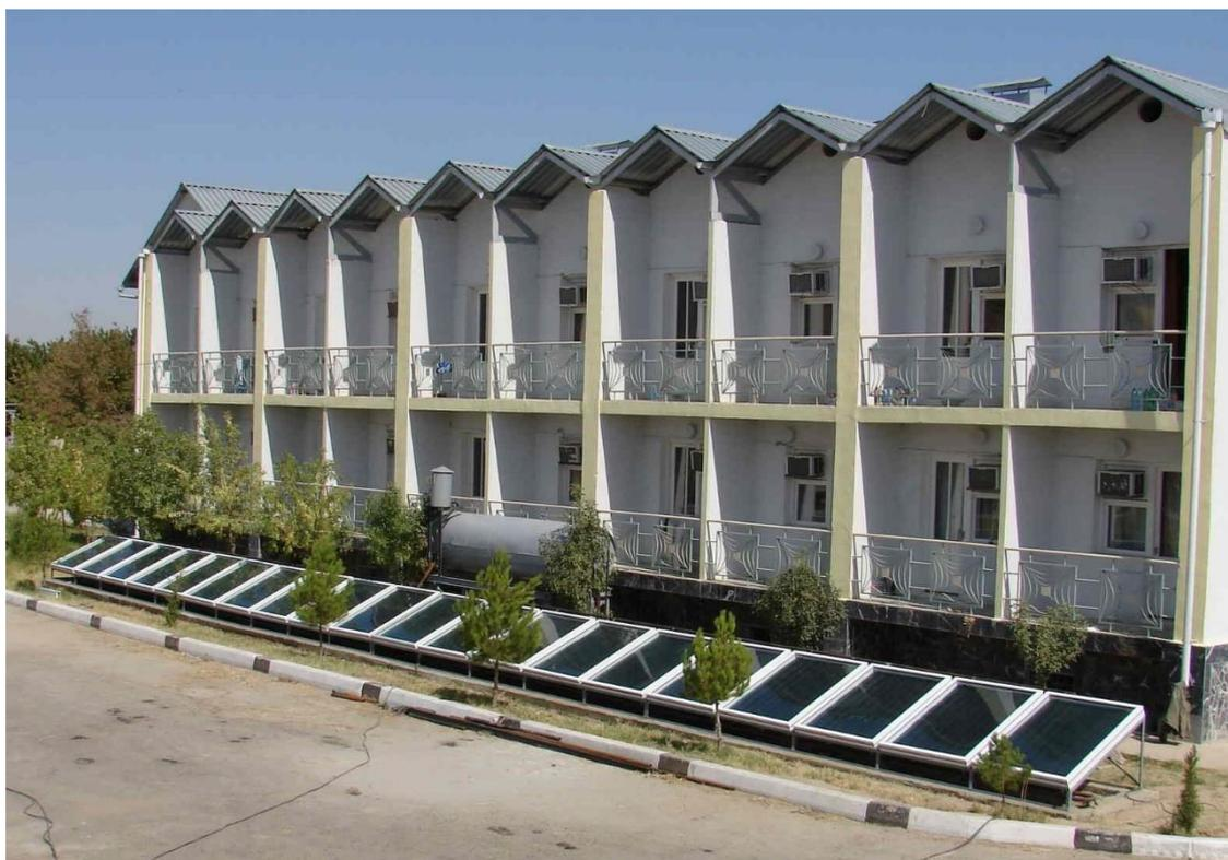
*Рис. 12. Установка солнечного горячего водоснабжения гостиницы базы отдыха «Лазурная» НГМК*
