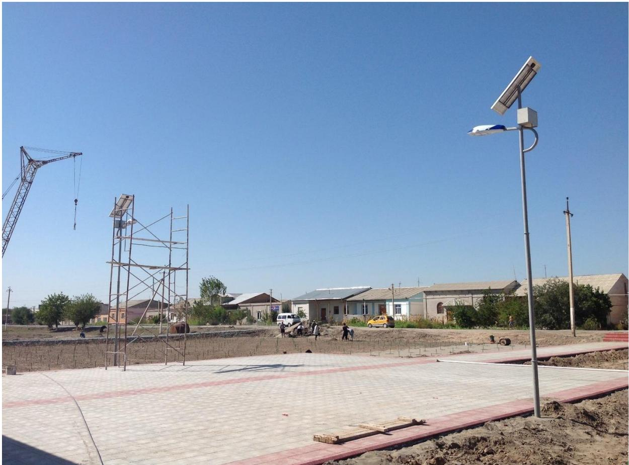
*Рис. 28. Установка солнечных панелей в уличном городском освещении*
