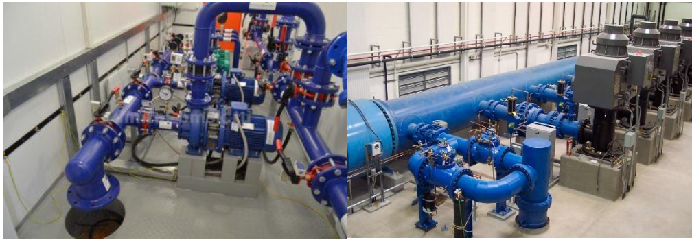
3.24-rasm. Nasos stansiyasida chastota o'zgartkich o'rnatilishi ko'rsatilgan
