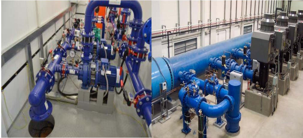
3.30-rasm. Nasos stansiyasida chastota o'zgartkich o'rnatilishi ko'rsatilgan
