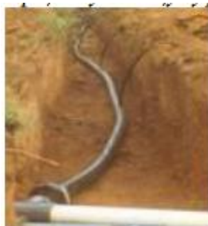
Б) распределительная труба
