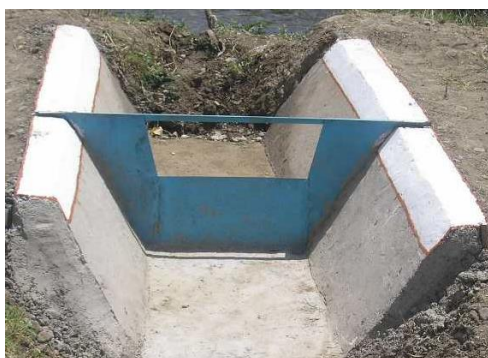
1-rasm. Chipoletti suv tashlagichining umumiy ko'rinishi
