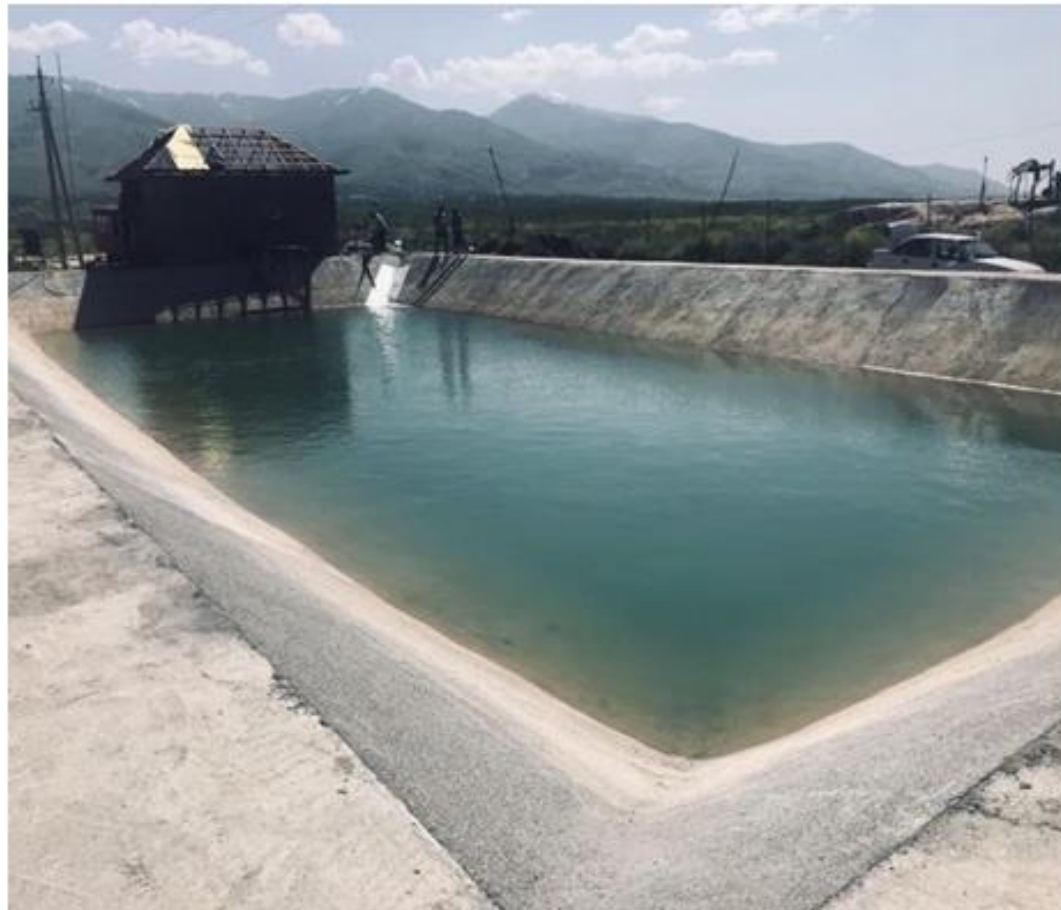
a) beton qoplamali hovuz
