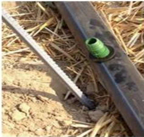
a) yomg'irlatib sug'orish tizimi yomg'ilatgichlarini montaj qilish
