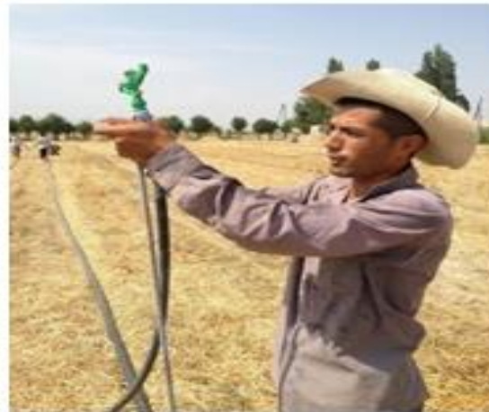
a) yomg'irlatib sug'orish tizimi yomg'ilatgichlarini montaj qilish
