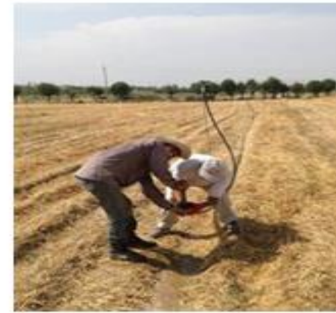
a) yomg'irlatib sug'orish tizimi yomg'ilatgichlarini montaj qilish
