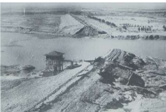
Разрушенная плотина Баньцяо (Китай)
