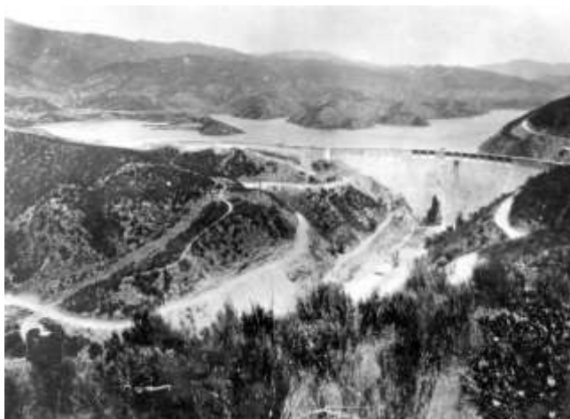
Проран, образовавшийся в теле плотине Сент-Френсис (США)
