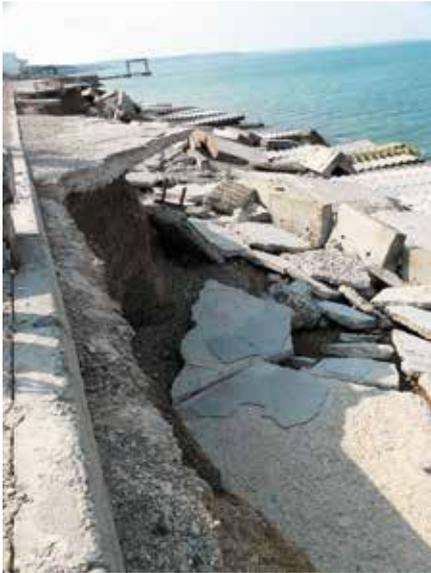
Рис. 1. Состояние берегоукрепительных сооружений в с. Песчаное
