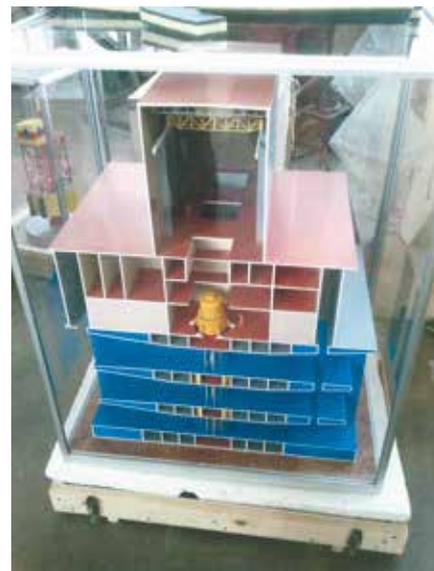
Рис. 5. Модель типового наплавного здания для Северной, Мезенской и Тугурской ПЭС
