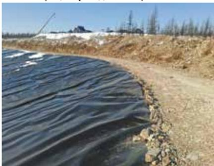
Рис. 8. Закрепление мембраны на берме
