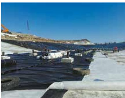
Рис. 7. Процесс укладки мембраны
