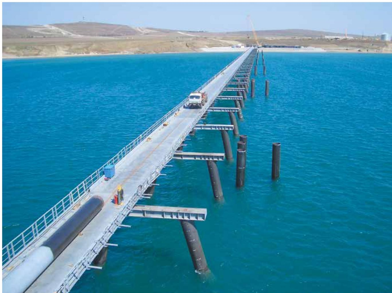
Рис. 2. Сваи и пролетные строения причала комплекса перевалки СУГ в порту Железный Рог
