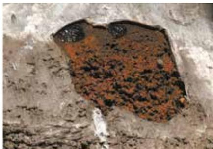
Рис. 6. Кавитационные разрушения основного металла камеры в местах срыва облицовки
