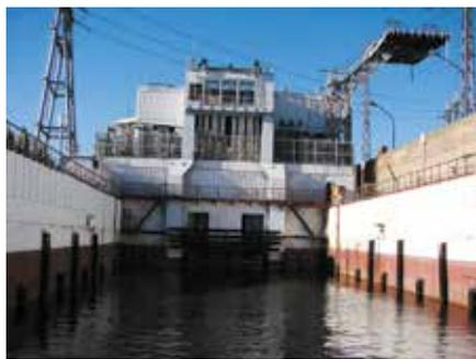
рых установлено в общей сложности 156 радиально-поршневых гидромоторов 1МР16С. Движение судовозной камеры происходит по судовозным путям рельсового типа с уклоном 1:10 и скоростью движения до 20 м/мин, она преодолевает расстояние 1747 м: верховой судовозный путь (ВСП) — 305,15 м; низовой судовозный путь (НСП) — 1189,66 м; поворотное устройство (ПУ) — 105,15 м; ремонтно-монтажная площадка (РМП) — 133,45 м.
