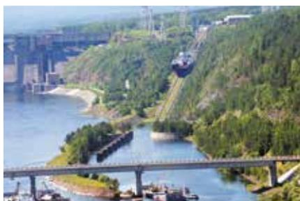
> Запас воды под днищем перевозимого судна (min 0,34 м) гарантированно обеспечивает его защиту от механического повреждения в случае экстренной остановки судовозной камеры.
