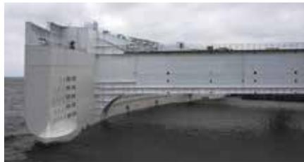
Рис. 2. Городецкий гидроузел: ремонтные плавучие затворы (батопорты)
