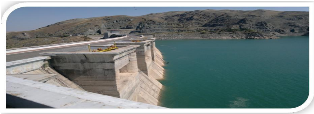
1.6-rasm. Suv omboridagi betonli to'g'on
