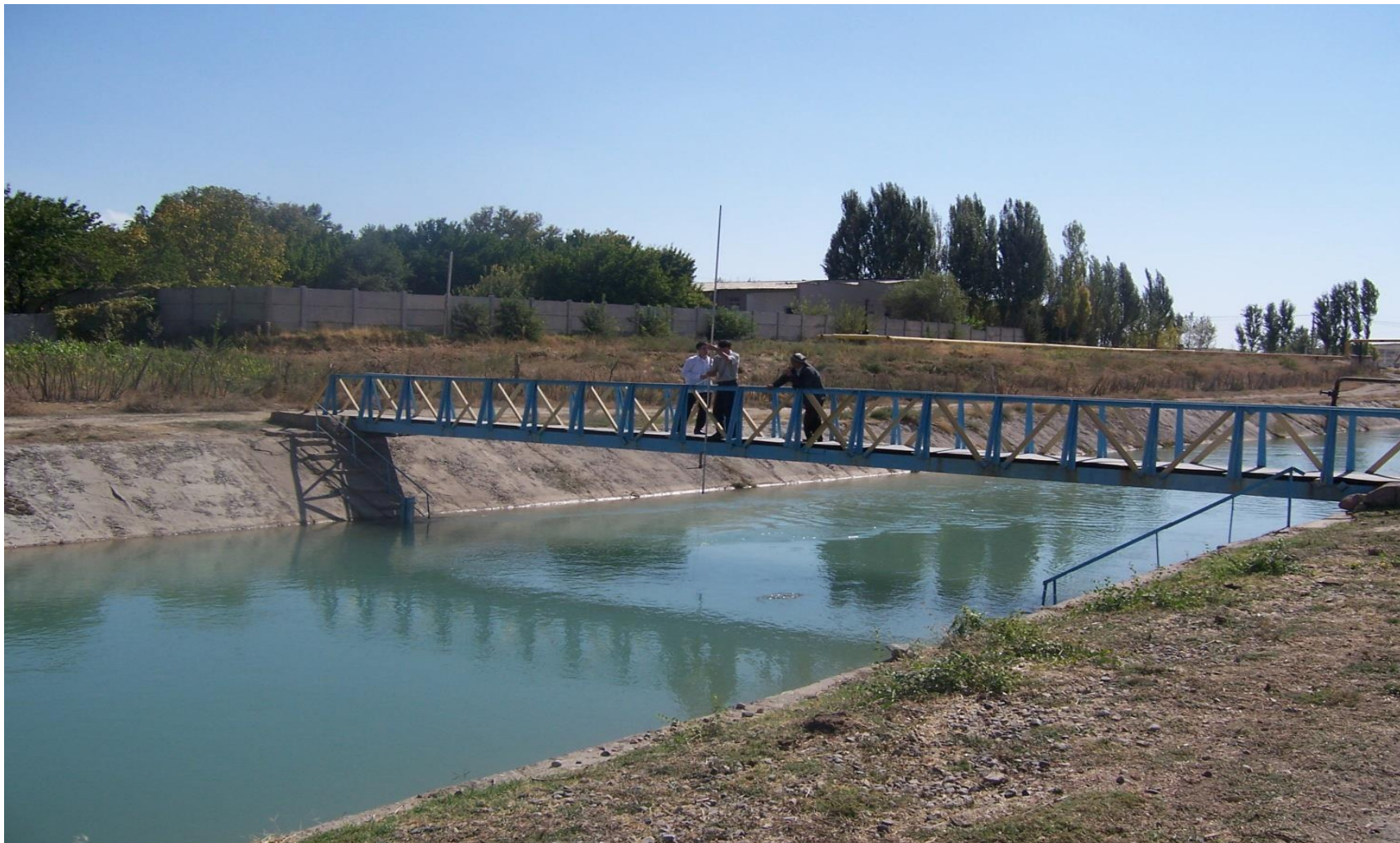
Паркент каналидаги гидропост
