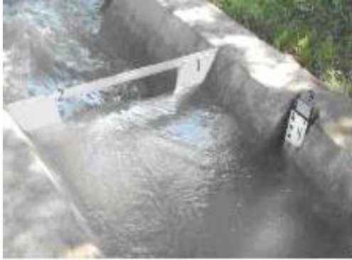
Рис.1. Водослив Чиполетти (вид с верхнего бьефа): водослив ВЧ-50; 2 - ребро жесткости; 3-успокоительная наивмерная рейка.
