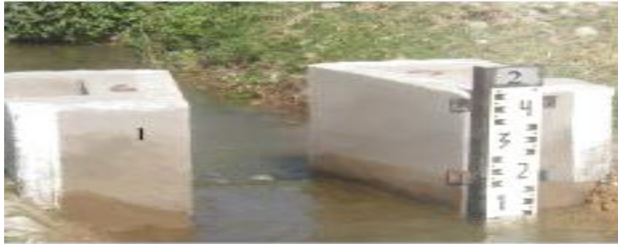
Рис. 3. Водомерный лоток САНИИРИ, подводная часть 1 - входные открышки, 2 - гидротехническая рейка
