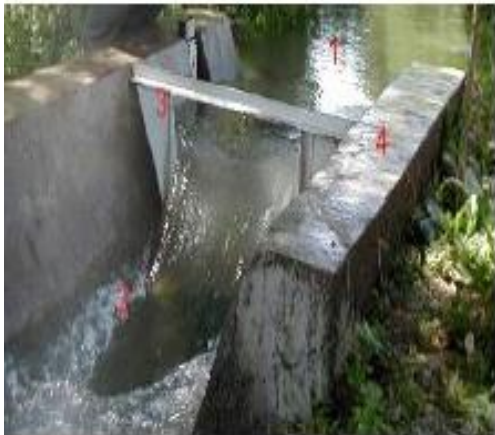
Рис.2. Водослив Чиполетти (вид с нижнего бьефа): подводный участок; 2 - отводящий участок; 3 - водослив; крепление бермы.
