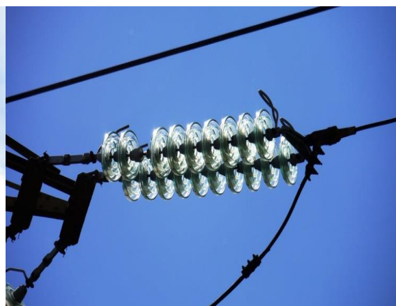
Расм – 2.15. Изолятор шодаларининг кўриниши (осма ва тортувчи)
