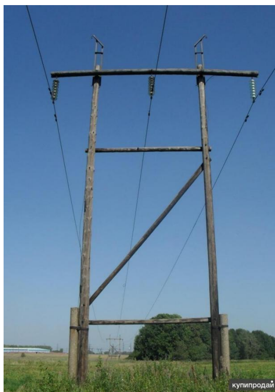
Расм – 2.7 35 кВ ва ундан юқори ёғоч ҳаво линияси таянчлари (оралиқ ва анкер таянчлари)
