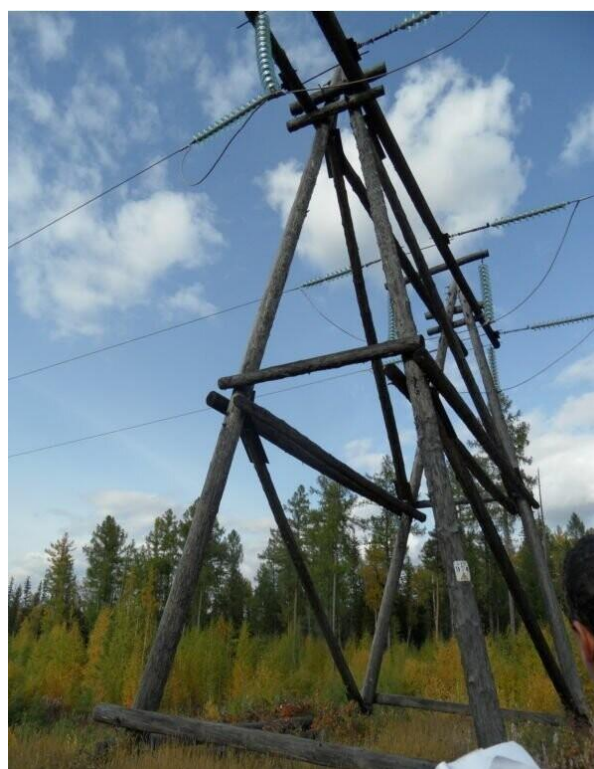
Расм – 2.7 35 кВ ва ундан юқори ёғоч ҳаво линияси таянчлари (оралиқ ва анкер таянчлари)
