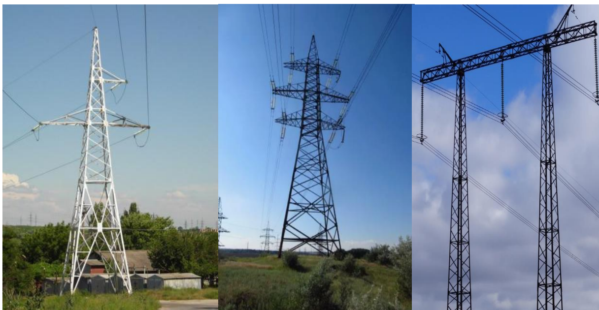
Расм – 2.11. 220 ва 500 кВ оралиқ пўлат таянчларнинг конструктив мисоллари (икки занжирли ва битта занжирли эркин турган, тортувчи тўсинчалари билан портал таянчлар)
