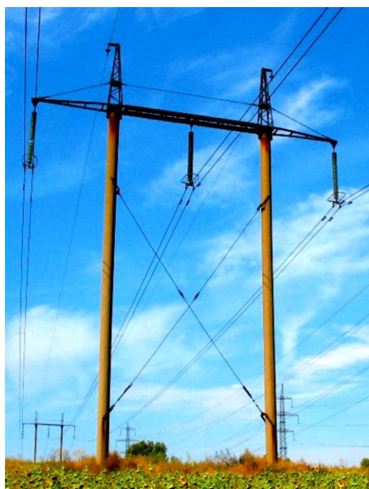
Расм – 2.9. 110 ва 220 кВ-ли оралиқ темир-бетон таянчларнинг конструктив намуналари(икки занжирли ва битта занжирли эркин)
