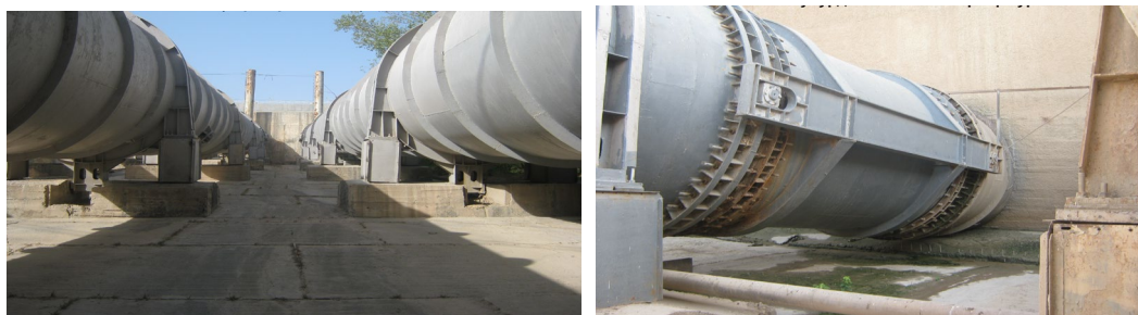
1 - rasm. Bosim quvurlari va kompensatorlar NS KMK diametri 3,60 m.
