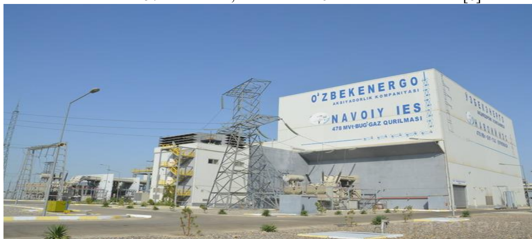
1-rasm. Navoiy IES 478 MVt Bug'-gaz qurilmasi.
