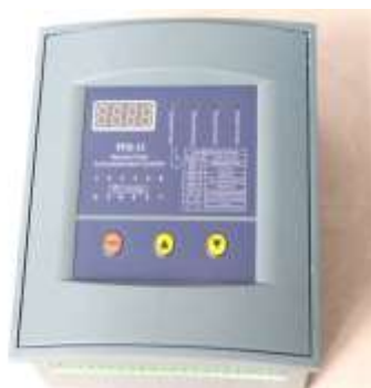
4.5- súwret. ETS reaktiv quwat derekleri ushın mikroprotessorli basqarıw sistemasında JKW58 PFR-12 tipli reaktiv quwat kompensatsiyası kontrolleri
