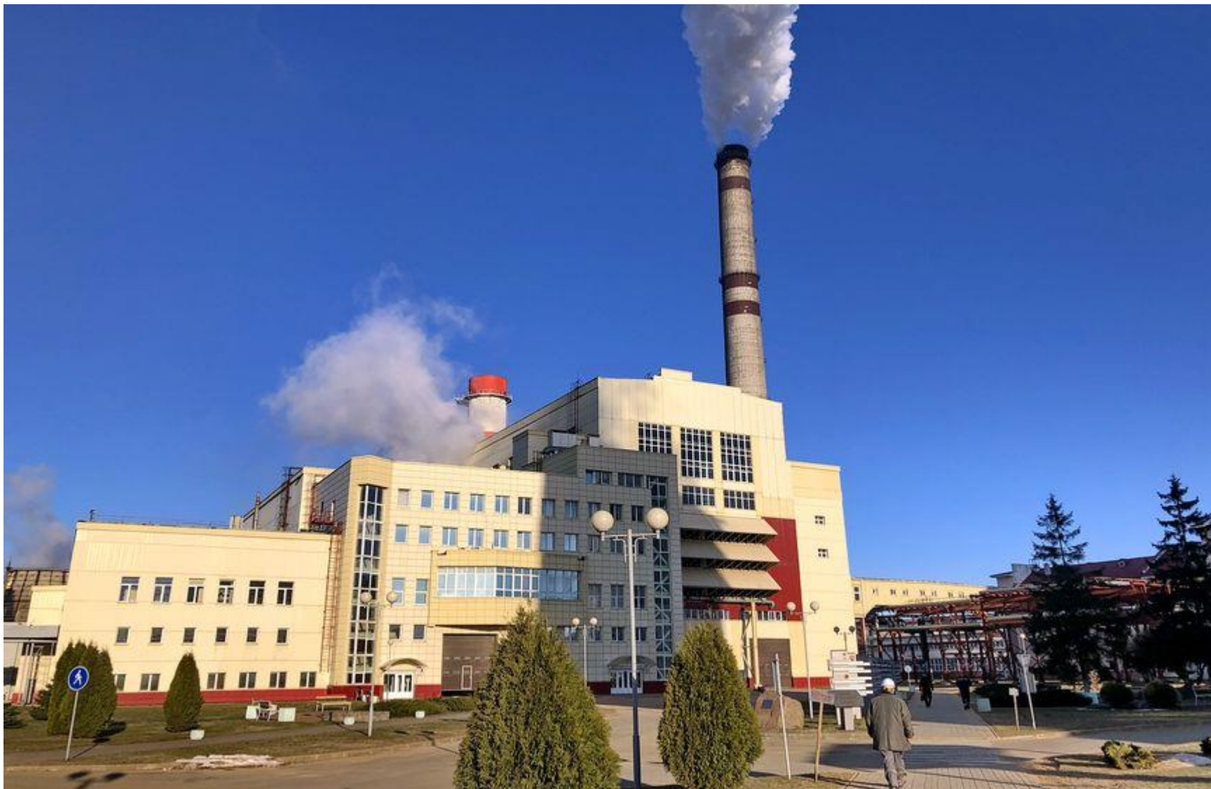
«Parogaz (bug` gaz)» turbinali elektrostansiyaning umumiy ko`rinishi
