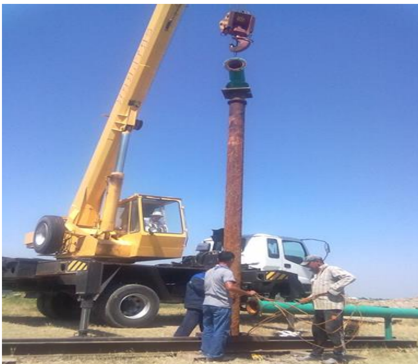
2.1-расм. Тик қудуқли насос агрегатрени автокран ёрдамида кўтариш.
