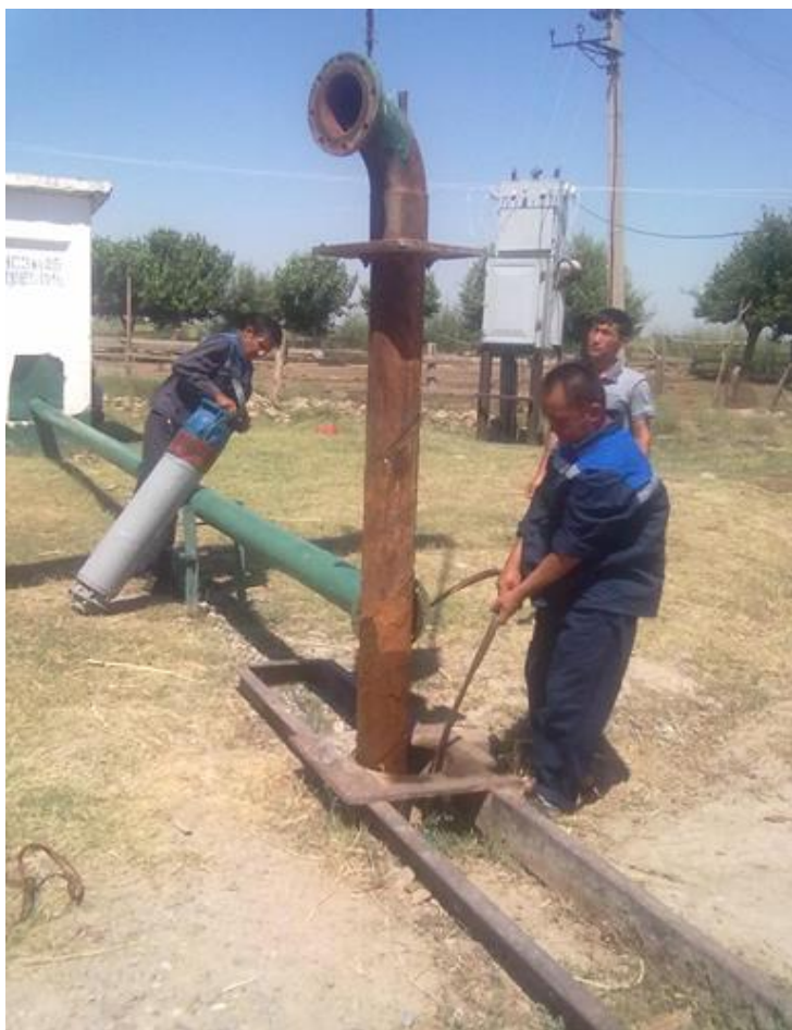
2.3 – расм. Тик қудуқли насос агрегатини қудуқдан тортиб чиқариш
