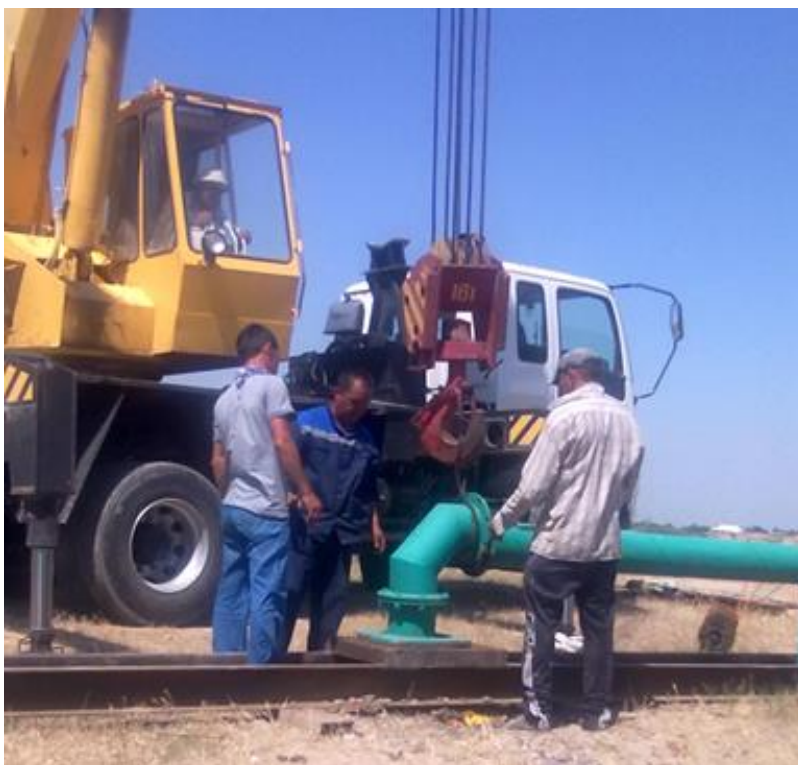
3.2 - расм. Тик қудуқли насос агрегати монтажини тугатиш
